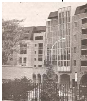
L'îlot de l'Hôtel des Postes
